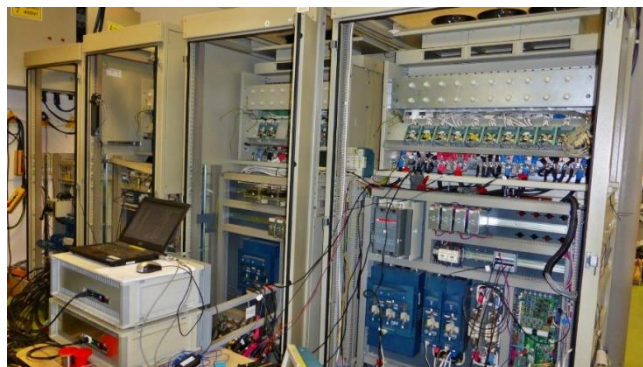
2. ábra: Nagyteljesítményű szünetmentes áramellátó rendszer szekrényei
